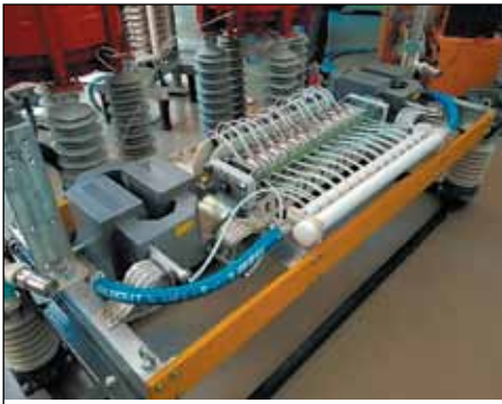
Рис. 1. Высоковольтный тиристорный модуль на тиристорах T283-1600
